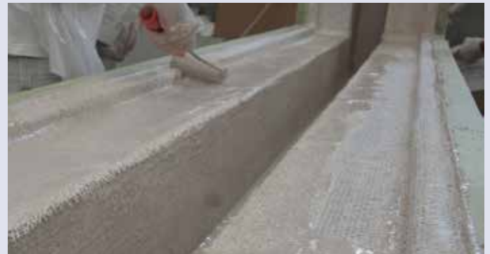
Чтобы ламинировать, нужно работать мокрым по мокрому. Быстрый способ нанесения A1 - с помощью кисти или валика.
